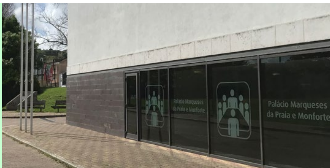
Palácio Marqueses da Praia e Monforte
